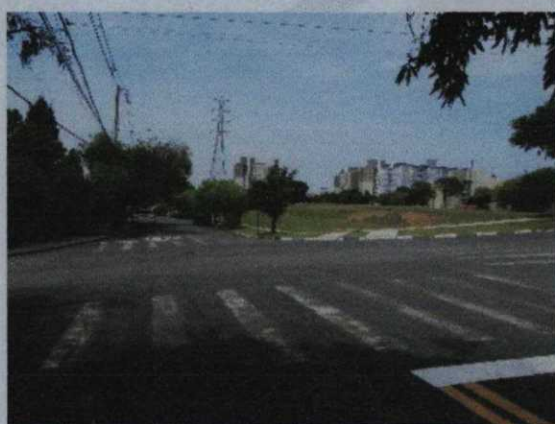
Figura 5 – Vista da rua – Lado
