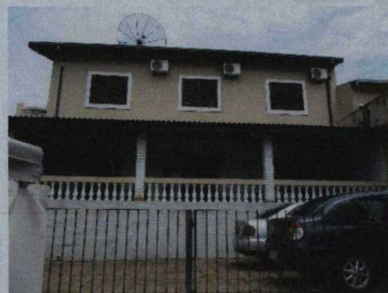
Figura 32 – Vista geral - Fundos
